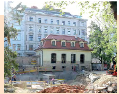
NEUES BIERLOKAL. Die Bauarbeiten im Belvedere-Park sind in vollem Gange.
